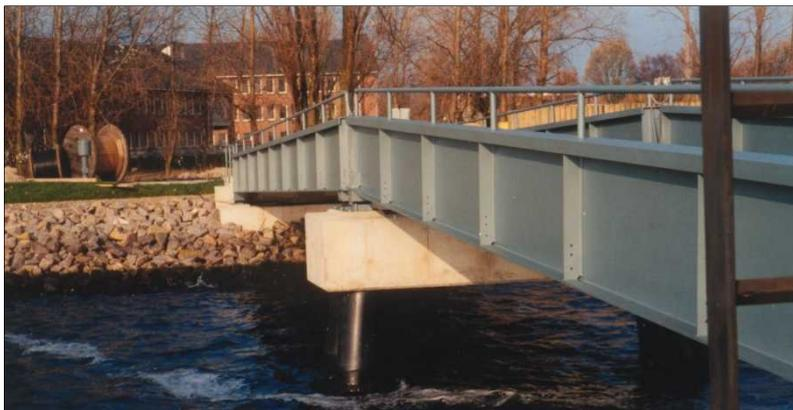
Die Übergangsbrücken bestehen aus einem festen Teil zwischen Ufer und einem in See gerammten Auflager sowie einem beweglichen Teil mit Übergangsklappe. Die Brücken liegen auf Elastomer- und Kunststoffrollenlagern. Die Fahrbahnen sind mit einem Kunststoffdünnbelag mit Quarzsandeinstreuung beschichtet.
