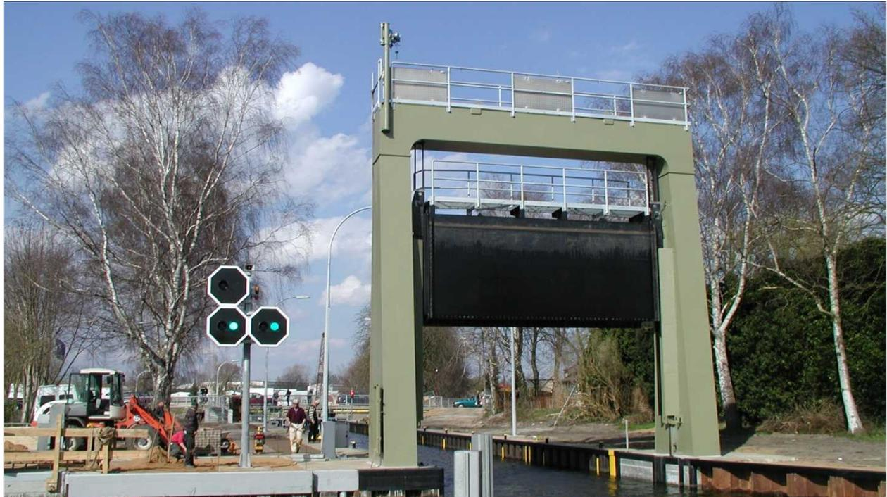
Im Auftrag des WSA Lauenburg übernahm die Ingenieurbüro Lorenz GmbH die Planungen für die „Instandsetzung der Schleuse Gürtitz“. Im Rahmen dieser Grundinstandsetzung an der Müritz-Elde-Wasserstraße waren sämtliche stahlwasser- und maschinenbaulichen Anlagen neu zu erstellen. Dazu gehörten ein Hubtor am Oberhaupt und ein Stemmtor mit integrierten Gleitschützen am Unterhaupt.
