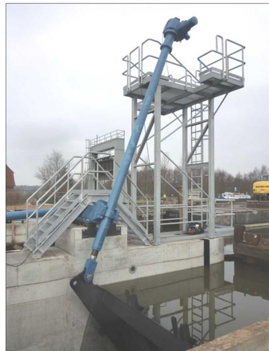
Zum Überqueren der Auflagerböcke der Antriebszylinder sind Stahltreppen mit dazwischenliegendem Podest angeordnet. Ein Podest dient der Bedienung (Handnotbetrieb) der Zylinder in Form einer Plattform mit Leiter in einer Höhe von ca. 5 m.
