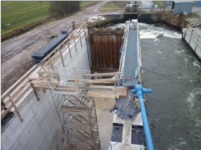
Die Verschlusskörper der Wehranlage wurden als Fischbauchklappe ausgeführt. Als Antrieb dienen Elektrohubzylinder mit integriertem Handantrieb. Diese sind einseitig an der Wehrklappe angeschlagen. Die Antriebsaufhängung erfolgt kardanisch. Die Antriebslagerungen liegen für die Antriebe beider Wehrfelder spiegelbildlich nebeneinander auf dem Mittelpfeiler zwischen den zwei Wehrfeldern.
