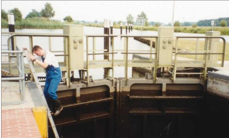
Das Ingenieurbüro Lorenz führte eine umfangreiche Bestandsaufnahme an 9 Schleusen der Müritz-Elde- bzw. Störwasserstraße (Schleuse Banzkow) durch. Auftraggeber war das Wasser- und Schiffsamt Lauenburg. Ziel der Bestandsaufnahme waren verlässliche Aussagen über baulichen Zustand und Betriebssicherheit der Schleusenverschlüsse (Stemm- und Klappstore, Füll- und Entleerungsschütze).
