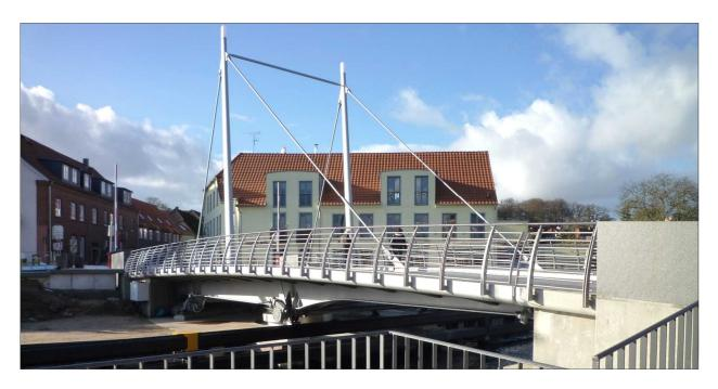
Für den Neubau der Drehbrücke Malchow plante und konstruierte das IBL die Antriebs- und Lagerungstechnik. Besonderheit der Konstruktion ist die Lagerung mit einem Drehlager, 6 paarweise angeordneten, elektromechanisch betätigten Exzenterlagern und dem Spitzenriegel. Der Drehantrieb erfolgt elektromechanisch per Triebstockgetriebe.
